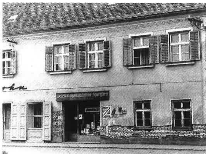
Gesamtansicht der Spenglerei Gutmann im Depisch-Haus am Grazer Platz
