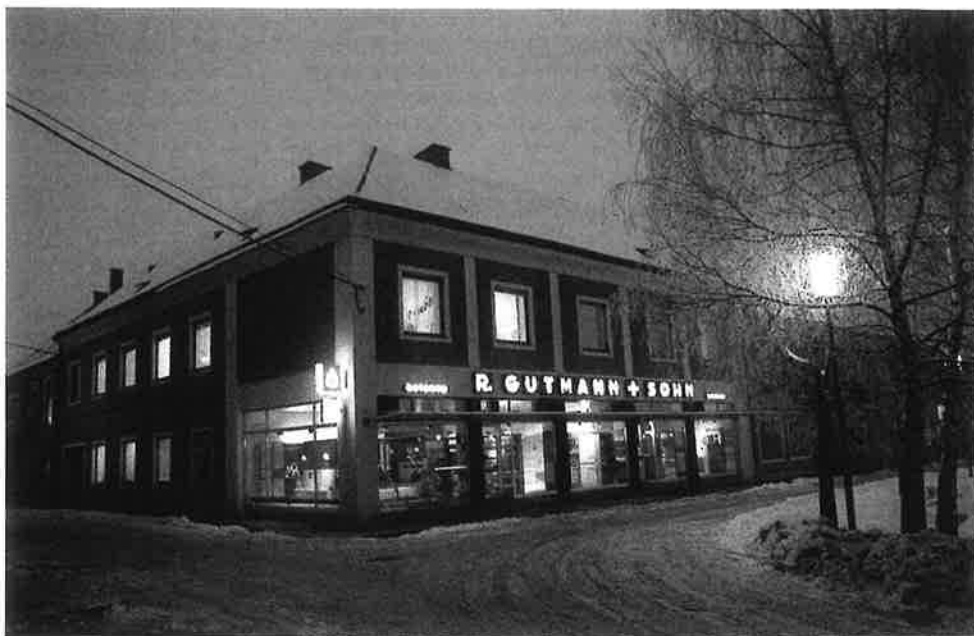
Das neue Firmengebäude mit Wohnung „Rudolf Gutmann + Sohn" am Grazer Platz 6
